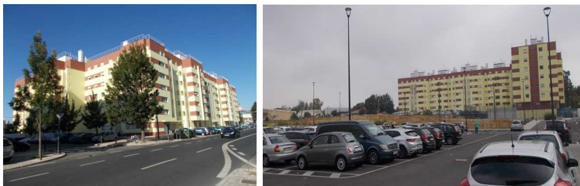
Imagem N.º 46 – Exterior dos edifícios do Bairro das Murtas
