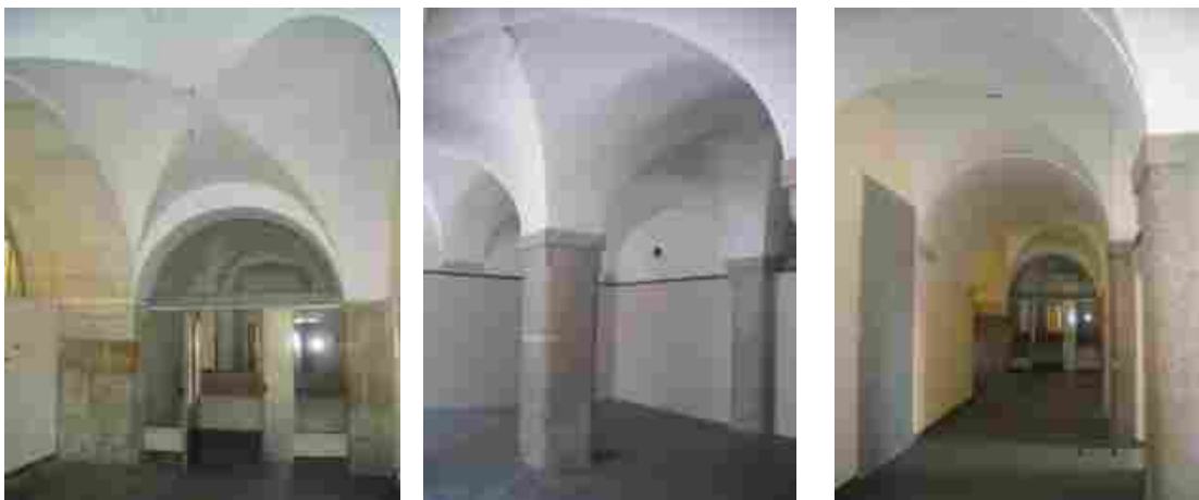
Piso inferior do edifício conventual
