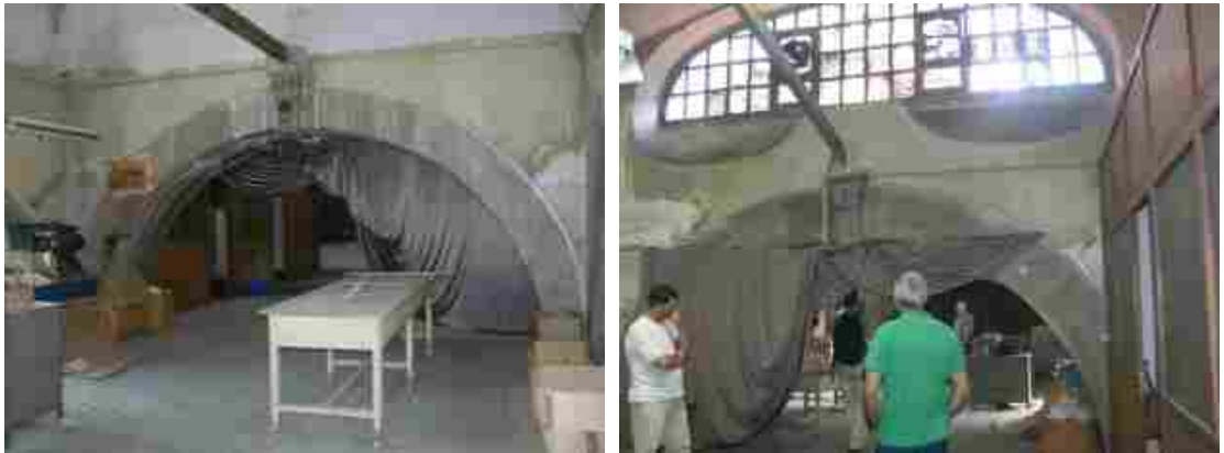
Pormenores do interior da nave da antiga igreja
