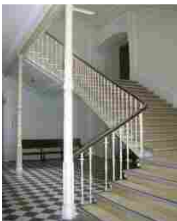
Átrio de entrada e escadaria principal
