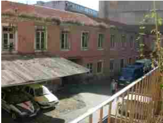
Fachada posterior do corpo que enforma o claustro
