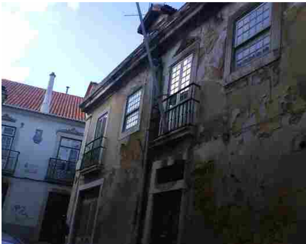
Fachada do corpo traseiro, na Travessa José Vaz de Carvalho
