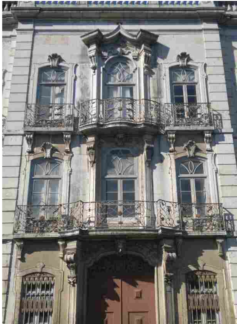
Corpo central da fachada, com marcação ostensiva de verticalidade
