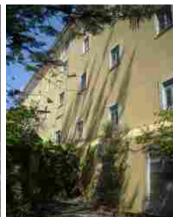
Fachada Sul do claustro do antigo convento
