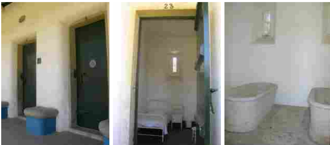
Pormenor das celas e dos balneários do Pavilhão de Segurança (8ª enfermaria do hospital)
