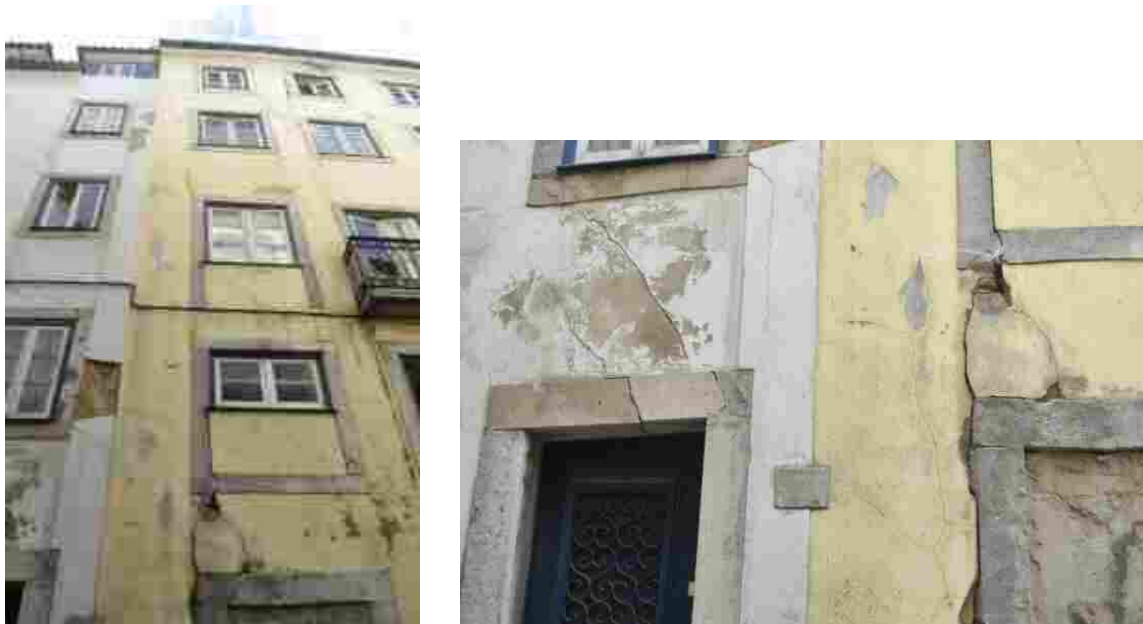
Figura 5.4 – Muros Rua do Arco da Graça, 2 a 4 e 6 a 12 (edifícios municipais)
