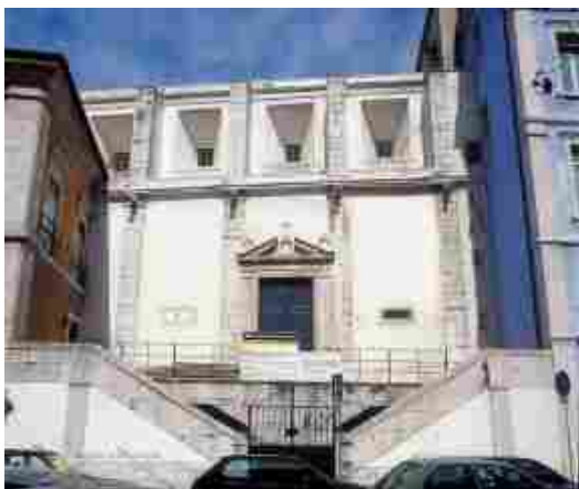
Fachada principal da Igreja
