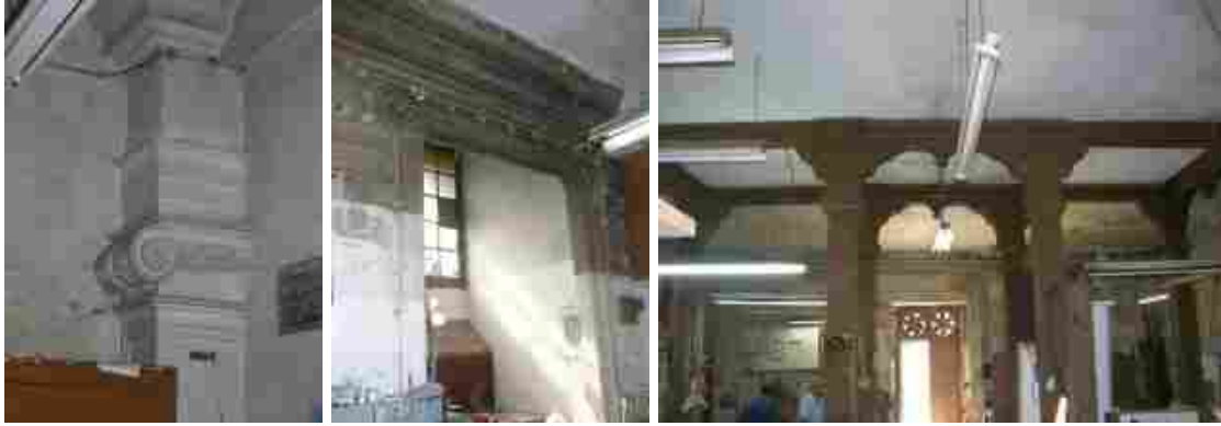
Pormenores de elementos arquitetónicos da antiga igreja
