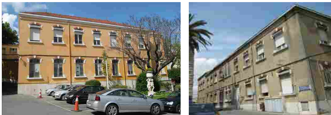
Fachadas da antiga escola de enfermagem Artur Ravara no interior do recinto hospitalar
