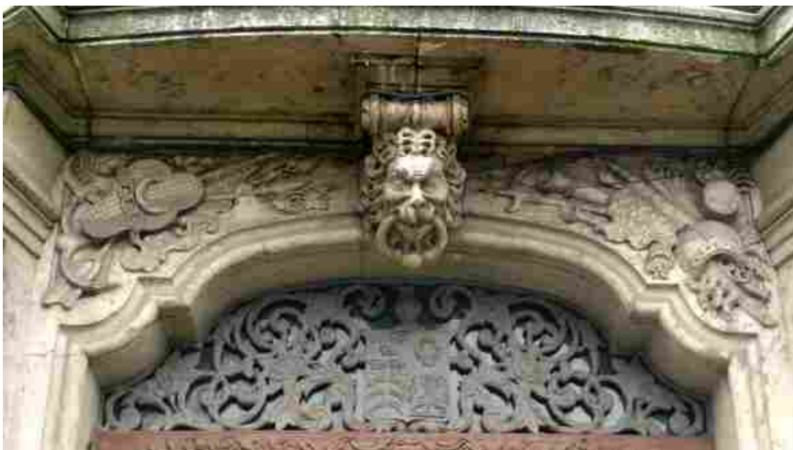
Brasão da família Costa Lobo, gravado na grade da sobreporta principal do palácio, datável da campanha de obras de 1867.
