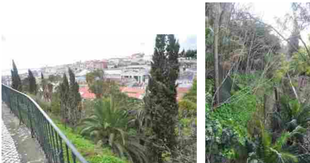
Figura 5.2 – Muros na encosta do Ateneu e Coliseu dos Recreios com árvores de grande porte
