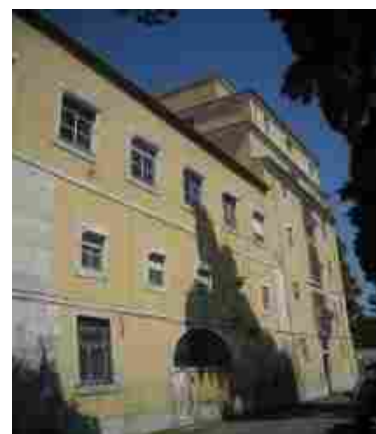
Fachada Nascente do antigo convento
