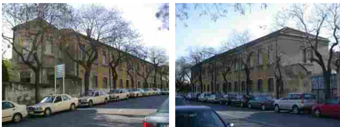
Fachada da antiga escola de enfermagem Artur Ravara na Alameda de Santo António dos Capuchos, frente ao Jardim dos Sabores
