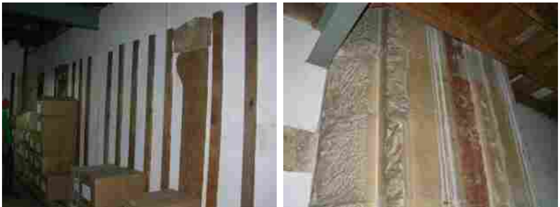
Pormenores de elementos arquitetónicos da antiga igreja hoje ocultos ou embutidos em paredes (colunas, pilastras)
