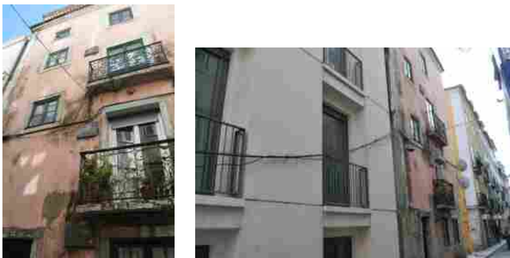
Figura 5.5 – Rua do Arco da Graça, 22- edifício confinante com a obra da EPUL
