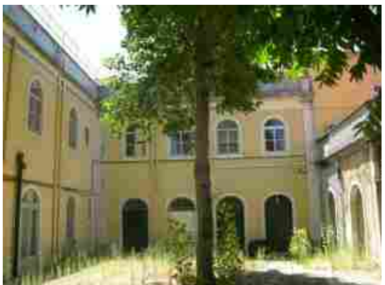
Fachada Poente do antigo convento
