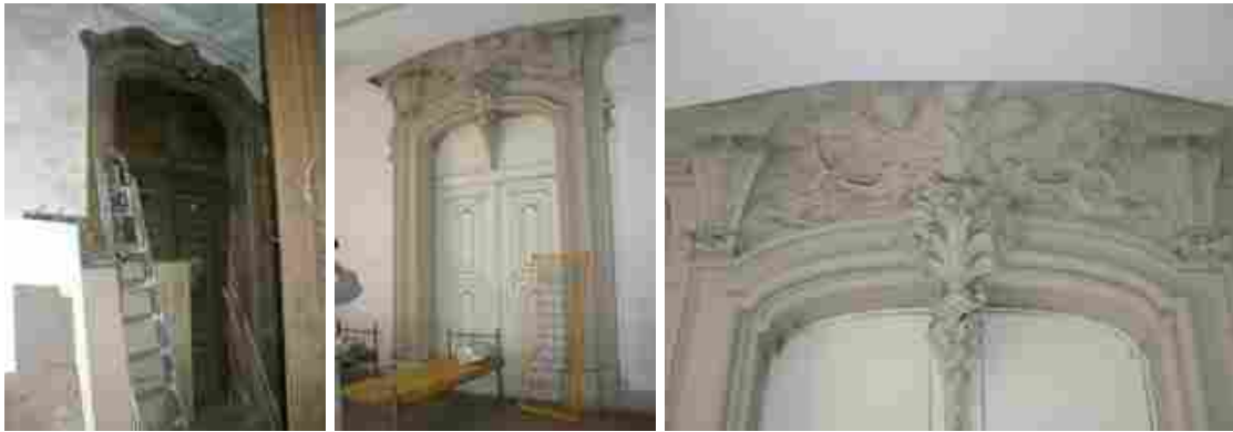
Pormenores de elementos arquitetónicos da antiga igreja
