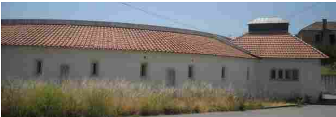
Exterior do Pavilhão de Segurança (8ª enfermaria do hospital)
