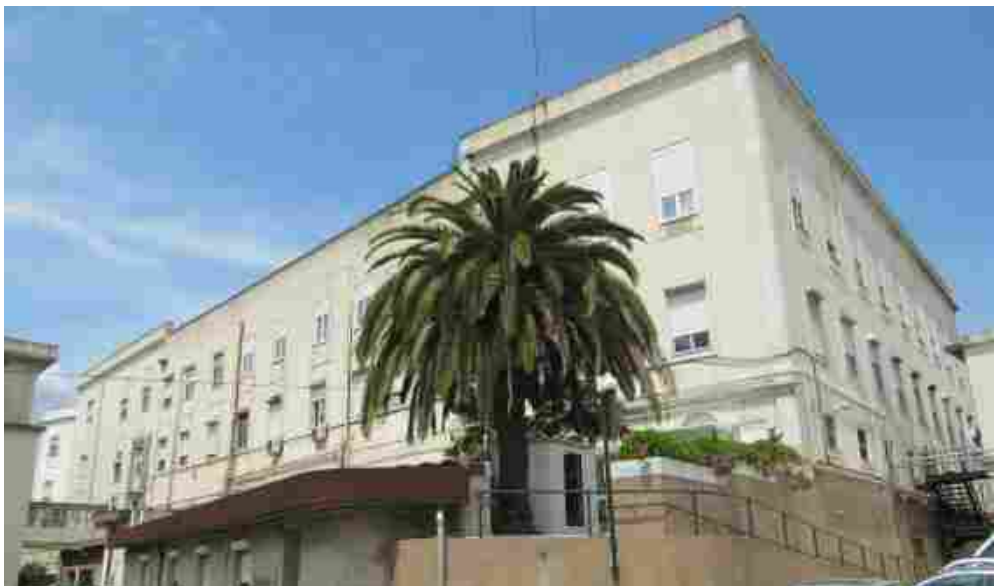
Fachada lateral e posterior do corpo que enforma o claustro pequeno do convento dos capuchos.
