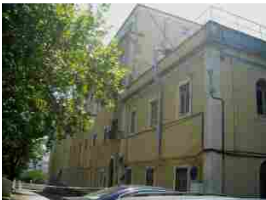
Fachada Norte do antigo convento
