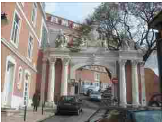
Vista geral do portal dos Pessegueiros
