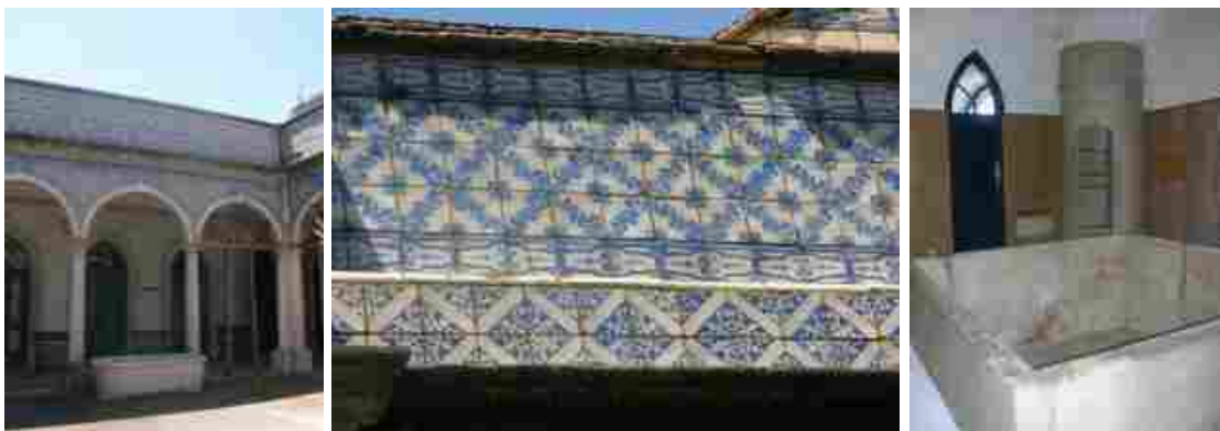
Pormentores do Balneário D. Maria II ( galeria em arcadas, azulejos de revestimento e zona de banhos no interior)
