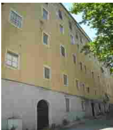
Fachada Norte do antigo convento
