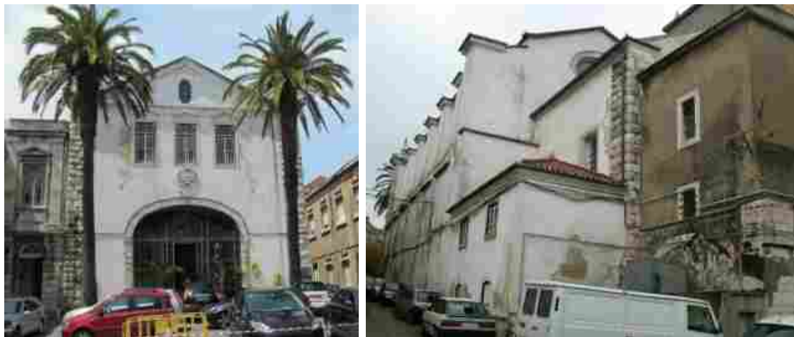
Fachada principal e lateral da igreja do antigo Convento dos capuchos.
