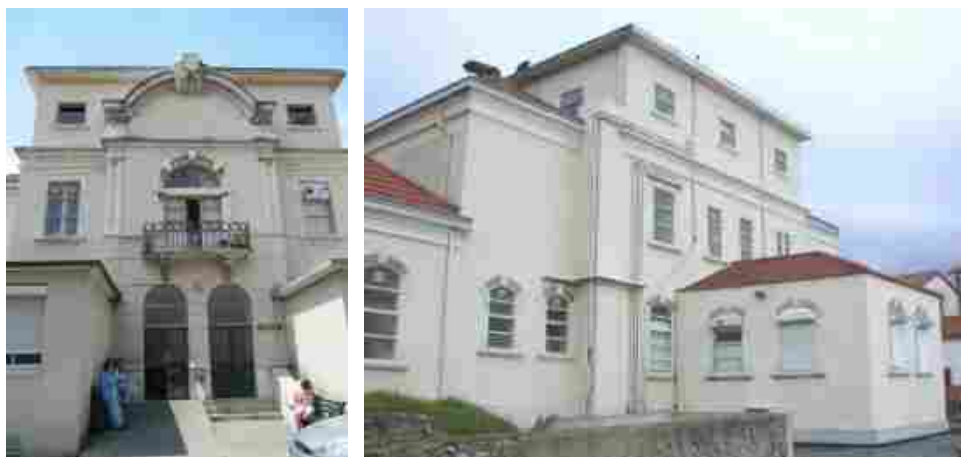
Fachadas da antiga escola de enfermagem Artur Ravara no interior do recinto hospitalar
