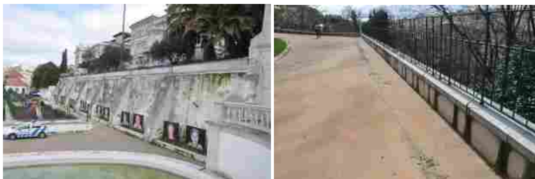
Figura 5.3 – Muros de contenção na escola básica n.º 29
