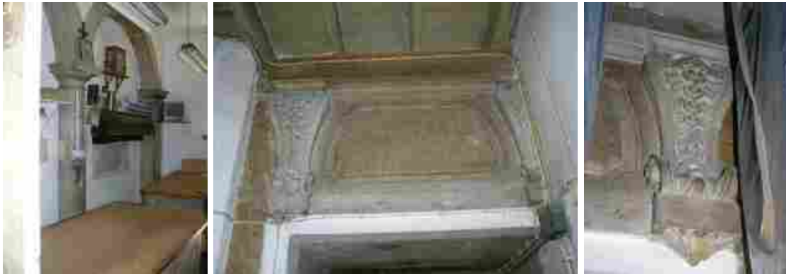
Pormenores de elementos arquitetónicos da antiga igreja hoje ocultos ou embutidos em paredes (colunas, pilastras, arcos, emolduramentos)
