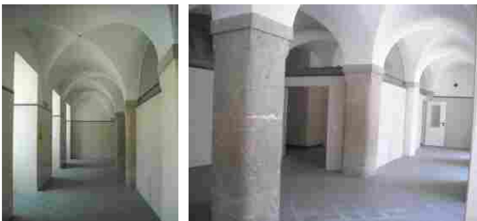
Piso inferior do edifício conventual
