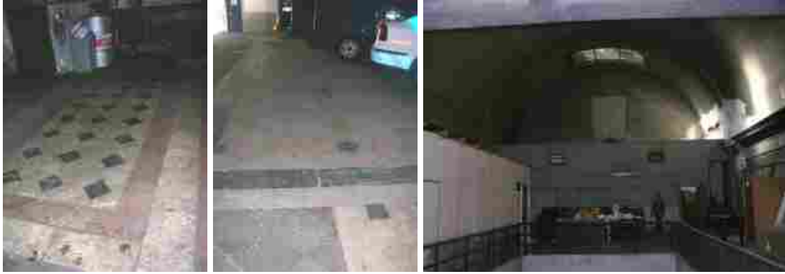
Pormenores do interior da nave da antiga igreja (pavimento e abóbada)
