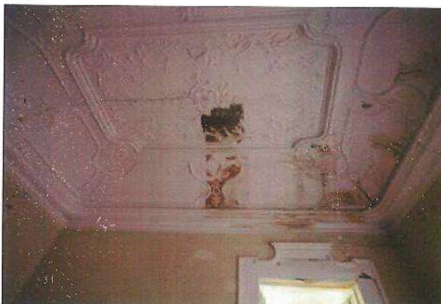
Fig. 31. Janela de Sondagem aberta no tecto da sala dos pássaros revelando ricas policromias sob tinta de cor branca, in Mariana, 2007, pág. 137.
