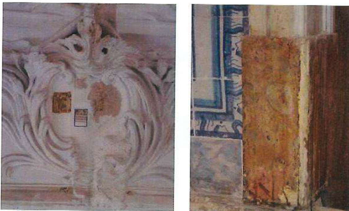
Fig. 26. Janela de sondagem aberta na capela e moldura de um vão interior no andar nobre, com pintura de fingidos posta a descoberto com sondagens, in Mariana, 2007, pág. 133.
