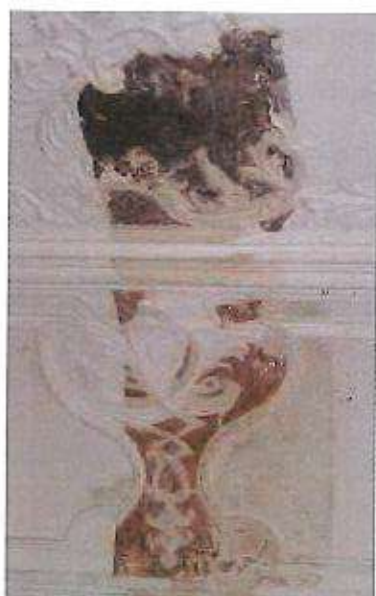
Fig. 31. Janela de Sondagem aberta no tecto da sala dos pássaros revelando ricas policromias sob tinta de cor branca, in Mariana, 2007, pág. 137.
