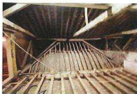
Fig. 15. Fotografias com as estruturas dos telhados “em tesouro” sob a atual cobertura de duas águas, in Mariana, 2007, pág. 109.
