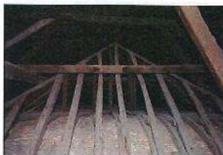
Fig. 15. Fotografias com as estruturas dos telhados “em tesouro” sob a atual cobertura de duas águas, in Mariana, 2007, pág. 109.
