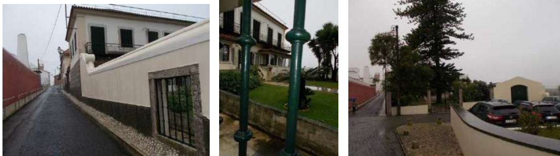
Frete virada à estrada da Ameixoeira e jardim interior / acesso pelo Largo do Ministro [Jan. 2016]
