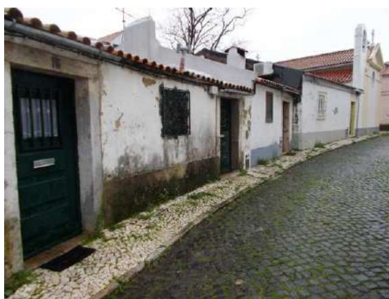
Frete dos edifícios - sentido norte [Jan. 2016]
