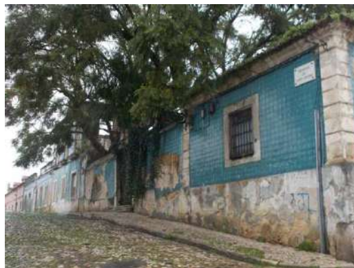
Vista da fachada com o acesso principal [Jan. 2016]
