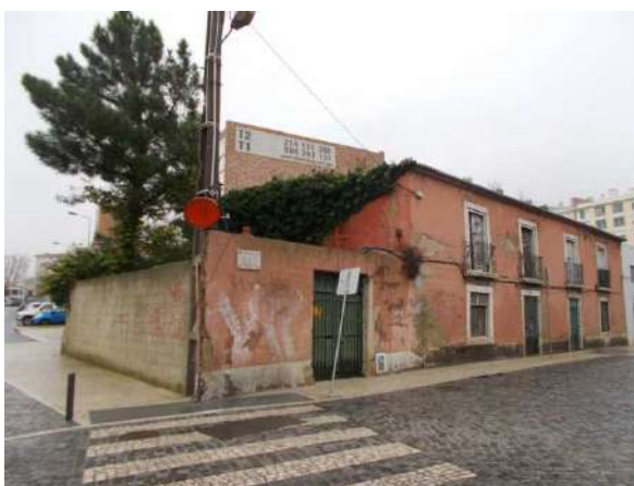
Vista da fachada com o acesso principal [Jan. 2016]
