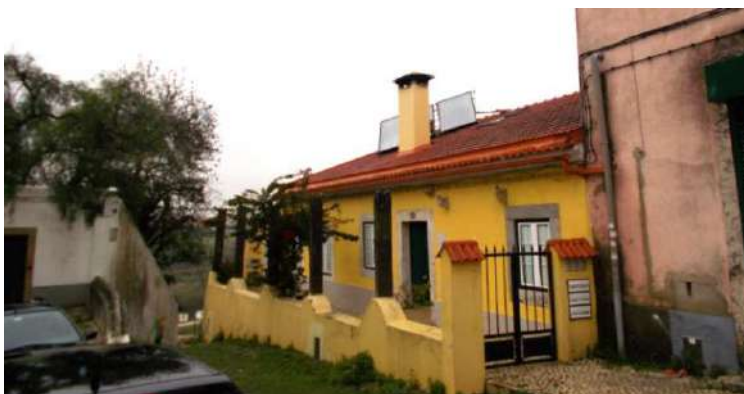
Vista da fachada com o acesso principal [Jan. 2016]
