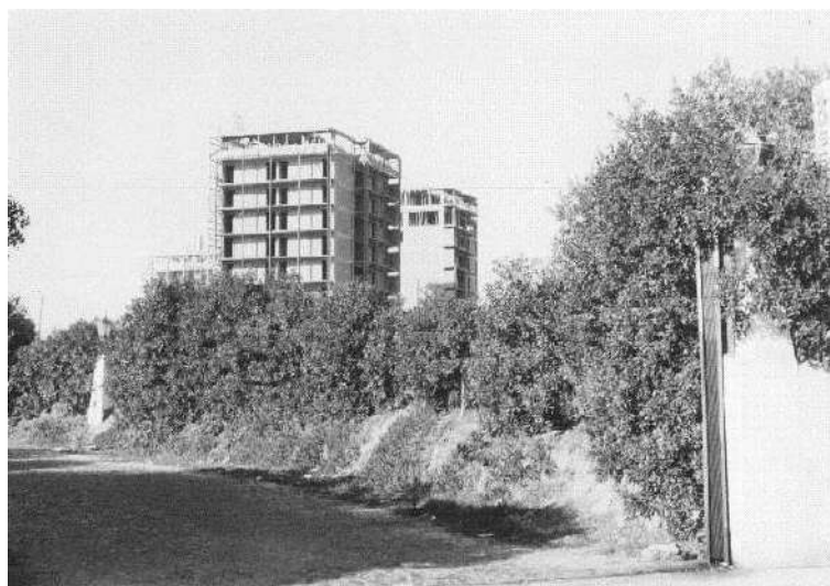
Prédio em construção junto da Azinhaga da Cidade em 1964 (Augusto de Jesus Fernandes, AML-Arquivo Fotográfico, PT/AMLSB/AJF/001555).
