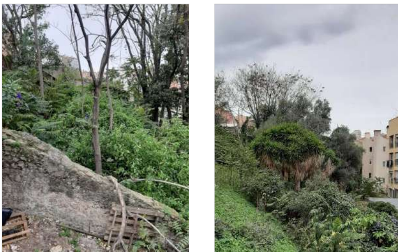
Figura 6 -Talude a norte da Rua de Entre Muros do Mirante
