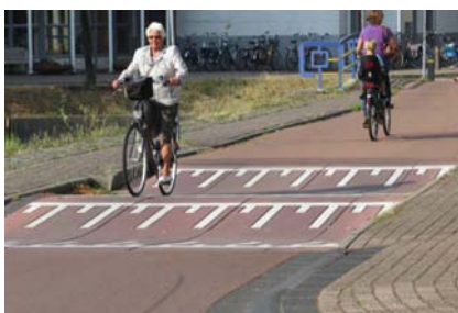
LOMBAS REDUTORAS DE VELOCIDADE – UTRECHT, HOLANDA
