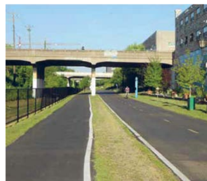
MINNEAPOLIS - PISTA CICLÁVEL JUNTO A LINHA FERROVIÁRIA
