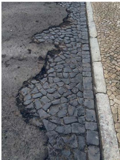
BETUMINOSO SOBRE CUBO DE BASALTO BAIRRO DOS ATORES
