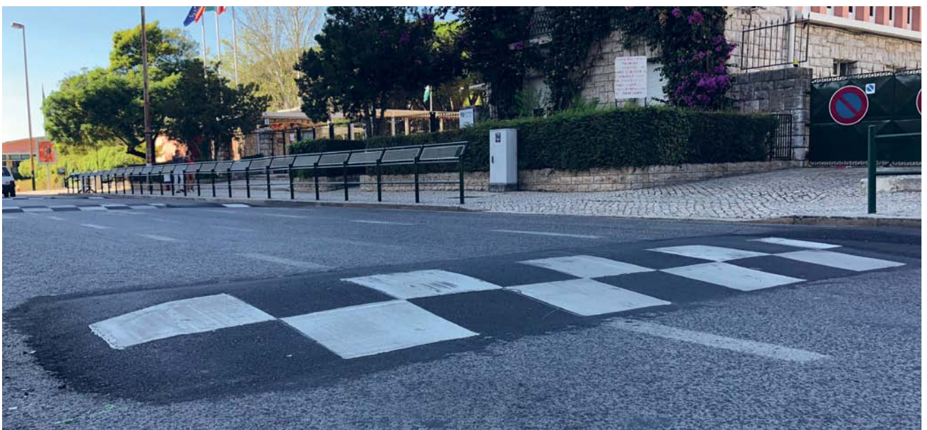
LISBOA - AVENIDA ENG. DUARTE PACHECO - LOMBA CURTA SEQUENCIAL DESENHADA PARA LIMITAÇÃO DE VELOCIDADE A 20 KM/H
