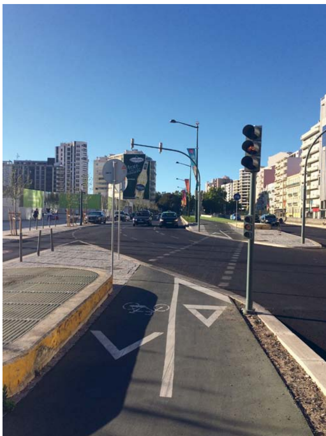
LISBOA - ATRAVESSAMENTO CICLÁVEL SEMAFORIZADO
