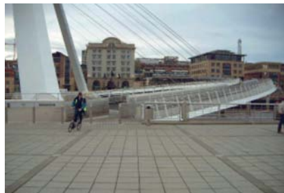
PASSAGEM SUPERIOR RAMPEADA
