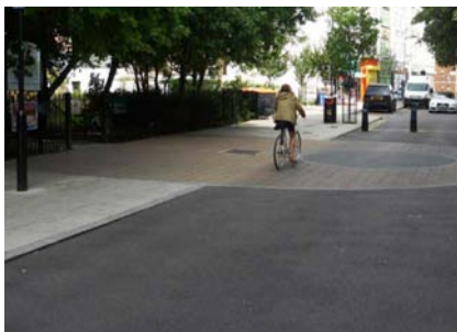
ALTERAÇÃO DE PAVIMENTO – HACKNEY, LONDRES, REINO UNIDO
