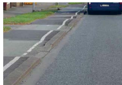
EXEMPLO DE MÁ SOLUÇÃO DE TRANSIÇÃO VERTICAL
