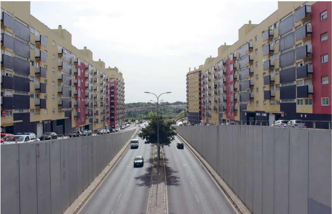
LISBOA – OLAIAS – INTERSEÇÃO DESNIVELADA.
