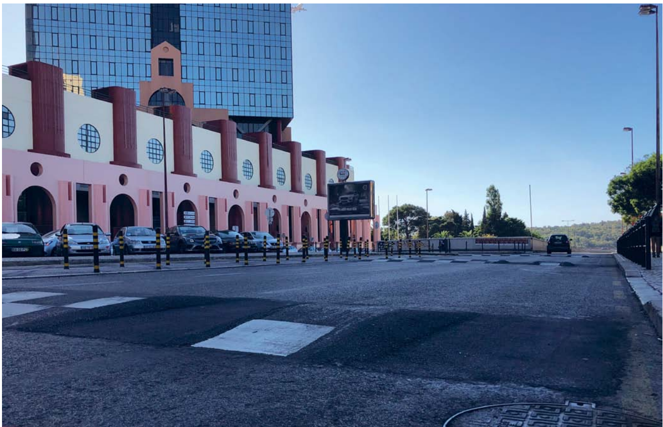
LISBOA - AV. DUARTE PACHECO - LOMBAS CURTAS RASGADAS PARA PASSAGEM DE TRANSPORTES PÚBLICOS
