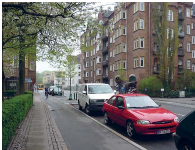
COPENHAGA - ZONA DE ESTACIONAMENTO CONTÍGUA A PERCURSO CICLÁVEL SEM FAIXA DE PROTEÇÃO
