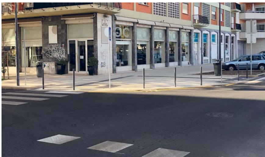
LISBOA – RUA DO ARCO DO CEGO – INTERSEÇÃO DESENHADA COM CURVAS DE RAIOS SIMPES
