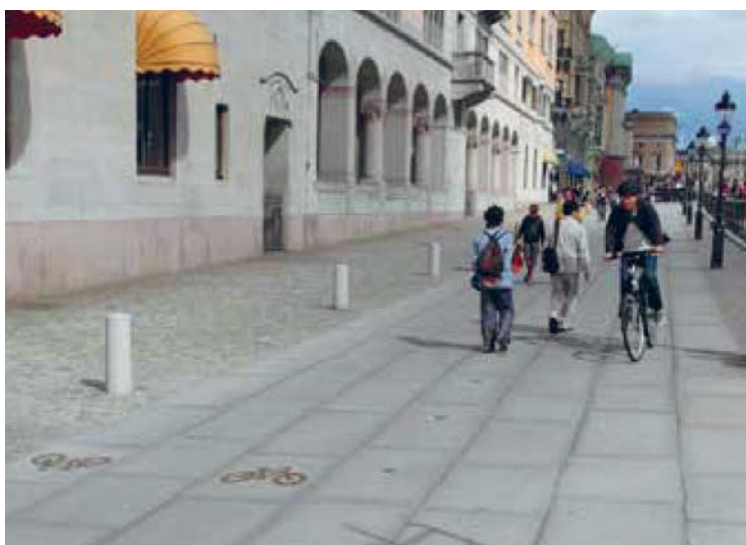
ESTOCOLMO - ZONA HISTÓRICA - IDENTIFICAÇÃO DE PERCURSO CICLÁVEL COM RECURSO A DISCOS METÁLICOS DE PAVIMENTO.
