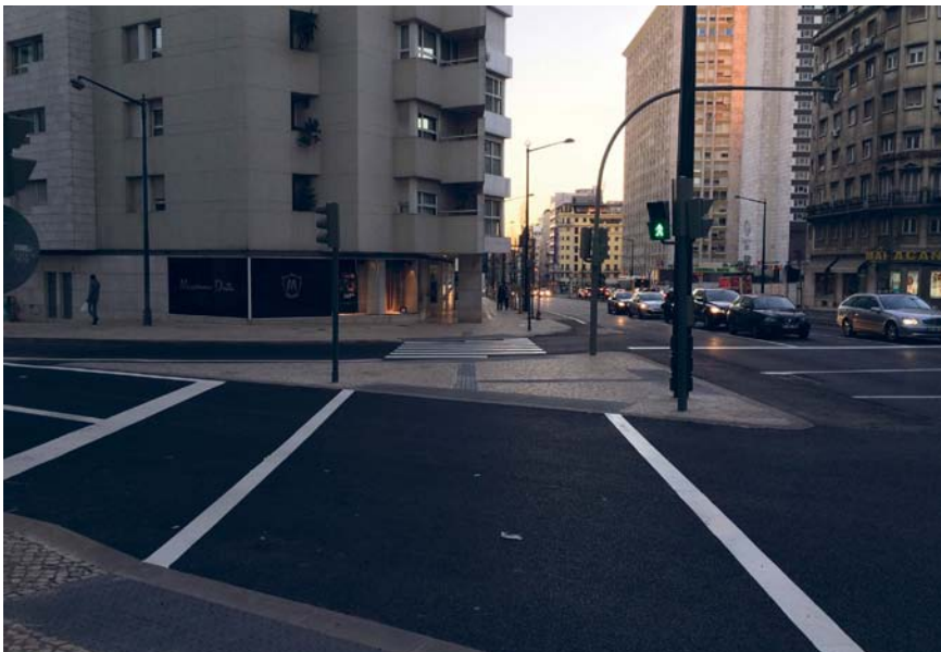
LISBOA – AVENIDA FONTES PEREIRA DE MELO – ILHÉU DIRECIONAL COM ATRAVESSAMENTO PEDONAL
