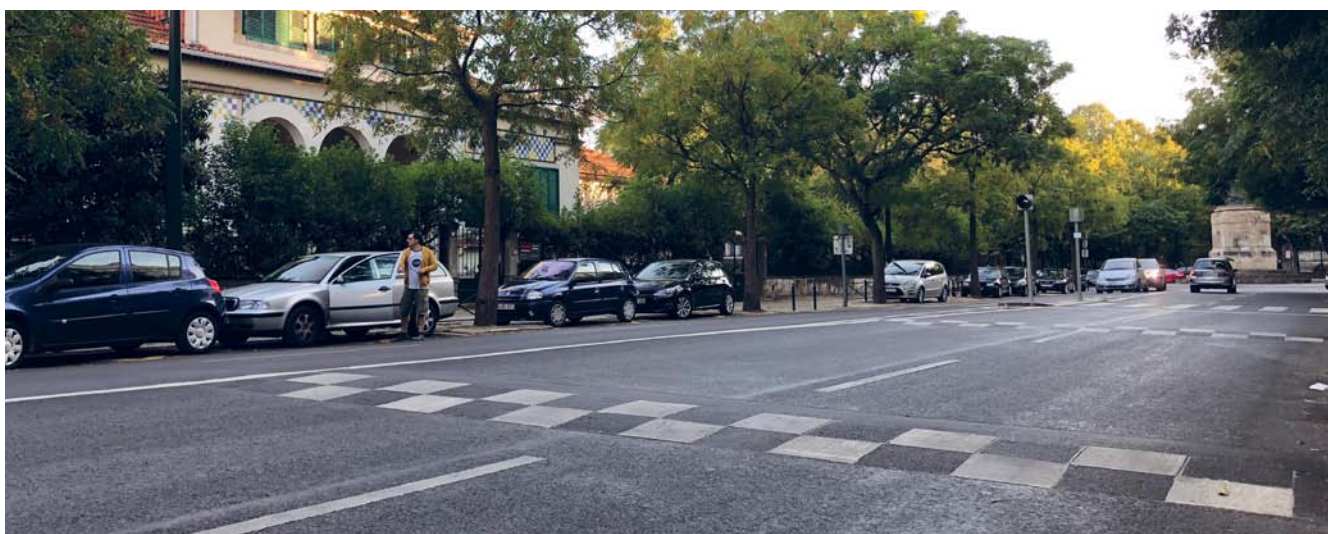
LISBOA - AVENIDA ÁLVARES CABRAL - LOMBA CURTA SEQUENCIAL DESENHADA PARA LIMITAÇÃO DE VELOCIDADE A 30 KM/H
