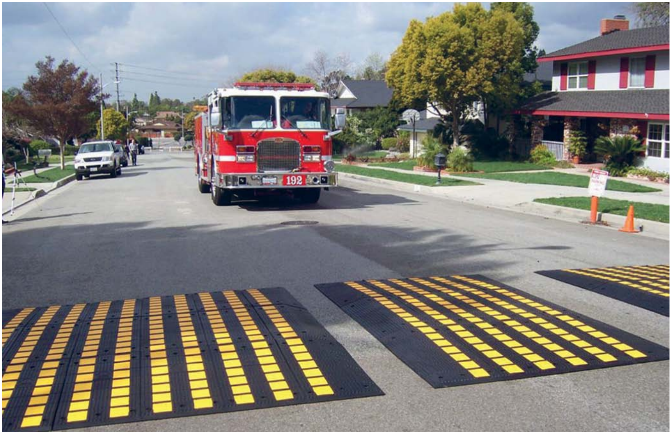
COLORADO - LOMBAS CURTAS RASGADAS PARA PASSAGEM DE VEÍCULOS DE SOCORRO
