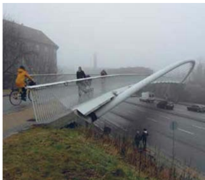
COPENHAGEN - PASSAGEM SUPERIOR CICLÁVEL E PEDONAL
