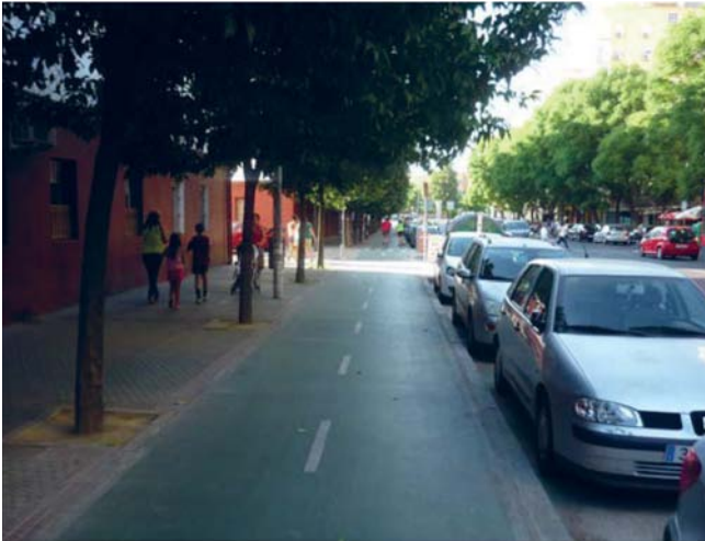
SEVILHA - ZONA DE ESTACIONAMENTO CONTÍGUA A PERCURSO CICLÁVEL SEM FAIXA DE PROTEÇÃO
