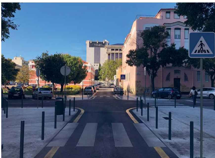
LISBOA - BAIRRO DO ARCO DO CEGO - ESTREITAMENTO DE INTERSEÇÕES COM RECURSO A PINTURA NA VIA.
