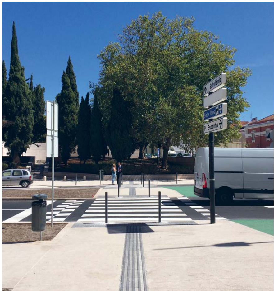
LISBOA - RUA DO ARCO DO CEGO - PASSADEIRA SOBRELIVADA
