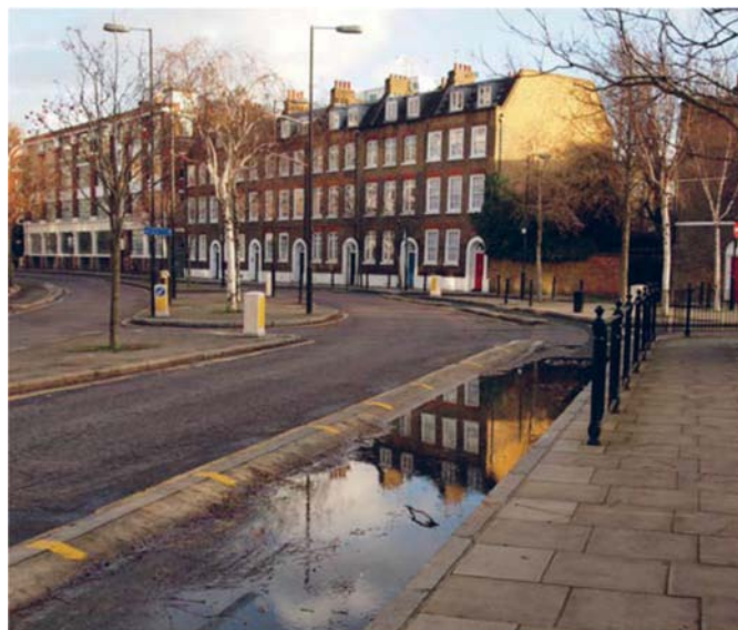
PROBLEMAS RESULTANTES DE INEFICIENTE DRENAGEM PLUVIAL
