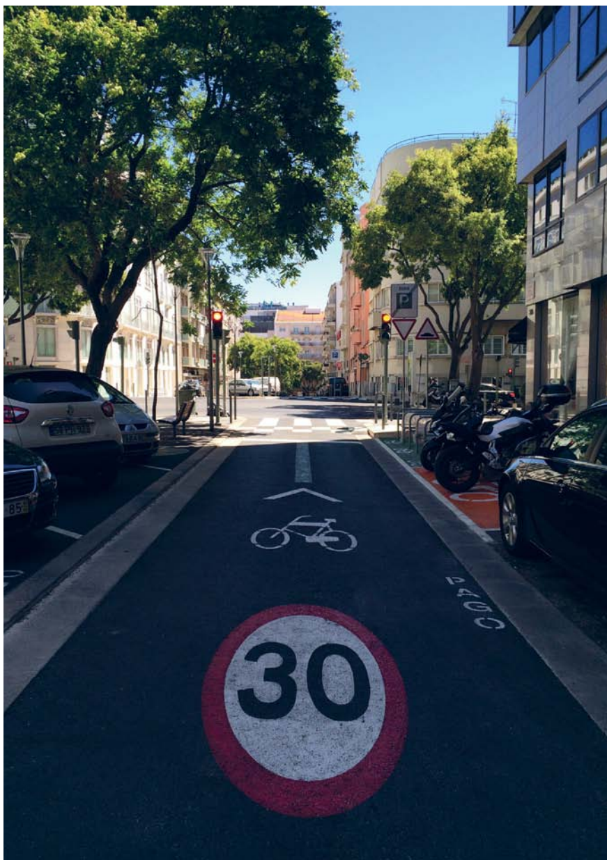
LISBOA – AV. PRAIA DA VITÓRIA – REDUÇÃO DA LARGURA DA VIA DE TRÂNSITO COM RECURSO A CONTRA-GUIA
