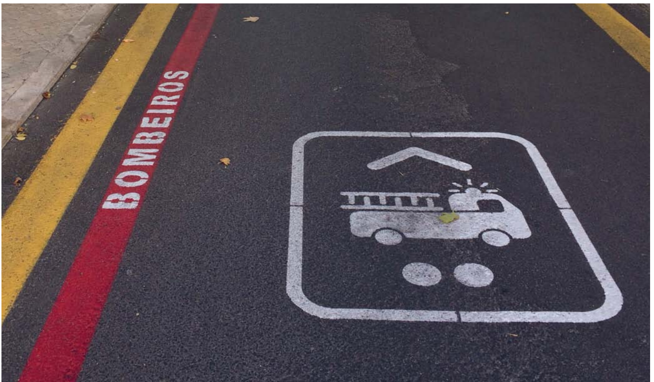
LISBOA – BAIRRO DO ARCO DO CEGO CIRCUITO DE EMERGÊNCIA DE ACESSO A VEÍCULOS DE COMBATE A INCÊNDIOS, ASSOCIADA A MARCA RODOVIÁRIA M12
