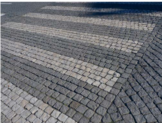
PASSADEIRA [MARCA M11] – CUBOS EM PEDRA
