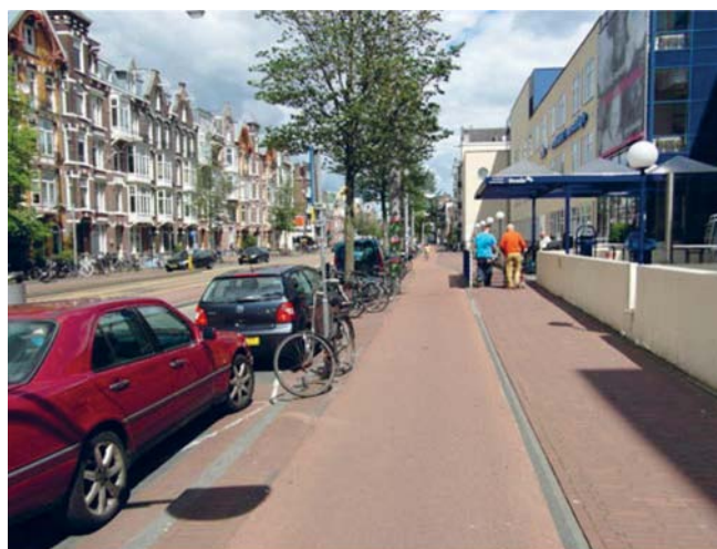
NEWHAM - ZONA DE ESTACIONAMENTO CONTÍGUA A PERCURSO CICLÁVEL SEM FAIXA DE PROTEÇÃO
