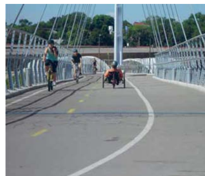
MINNEAPOLIS - PISTA CICLÁVEL SOBRE VIA RODOVIÁRIA
