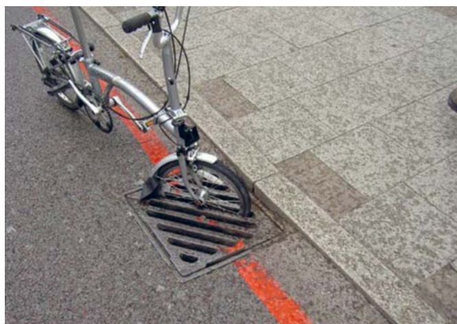
TAMPA METÁLICA DE SUMIDOURO DESADEQUADA PARA PERCURSOS CICLÁVEIS
