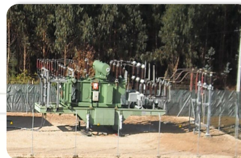
Subestação Móvel
