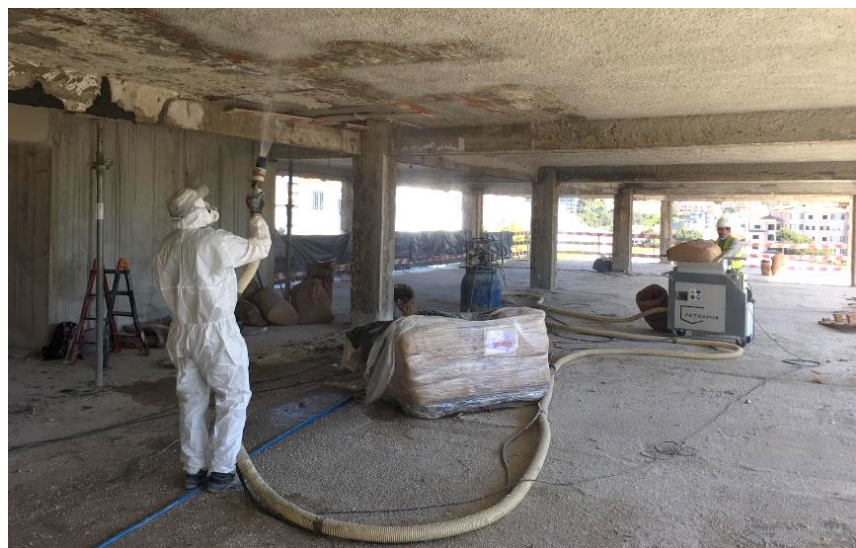
Proteção ao fogo da face inferior das lajes
