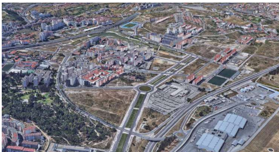
Figura 13 – Perspetiva da Alta de Lisboa vista de sudeste. Fonte: Google Earth©
