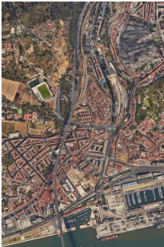
Vale de Alcântara Vista aérea
