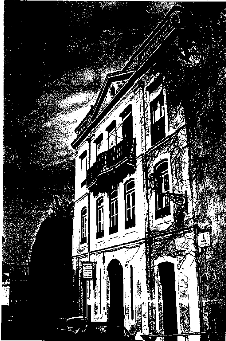
PRÉDIO DE RENDIMENTO Rua Costa do Castelo nº 2-6 (Freg. de São cristóvão-São Lourenço)
