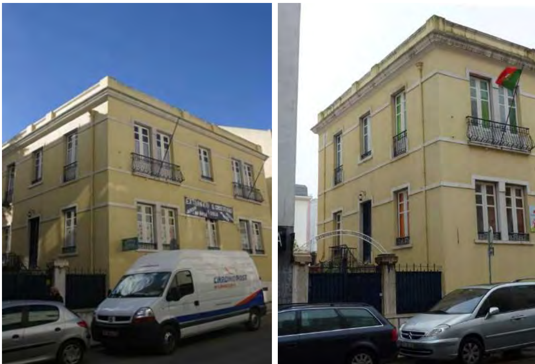
Aspeto da moradia a partir da rua
