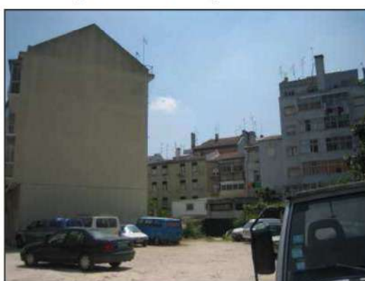
Figura 25 – Localização do Silo P3
