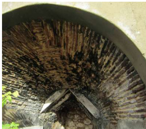
Fig. 5 e 6- A boca do forno emparedada com a abertura para entrada de combustível e tecto abobadado da entrada para a boca do forno melhor conservado.
