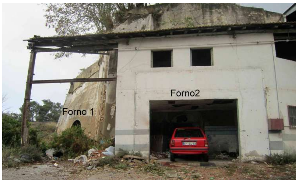
Fig. 3- Vista geral do primeiro complexo dos Fornos de Cal da Pedreira do Alvito: a estrutura antiga com a entrada para a boca de um forno, após demolição de uma edificação que lhe estava adossada e a cobria, no lado esquerdo da imagem. No lado direito da imagem, a estrutura antiga ainda tapada pela construção recente de uma garagem (no interior há outra boca de forno adaptada a chaminé de cozinha).
