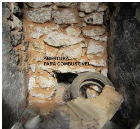
Fig. 5 e 6- A boca do forno emparedada com a abertura para entrada de combustível e tecto abobadado da entrada para a boca do forno melhor conservado.
