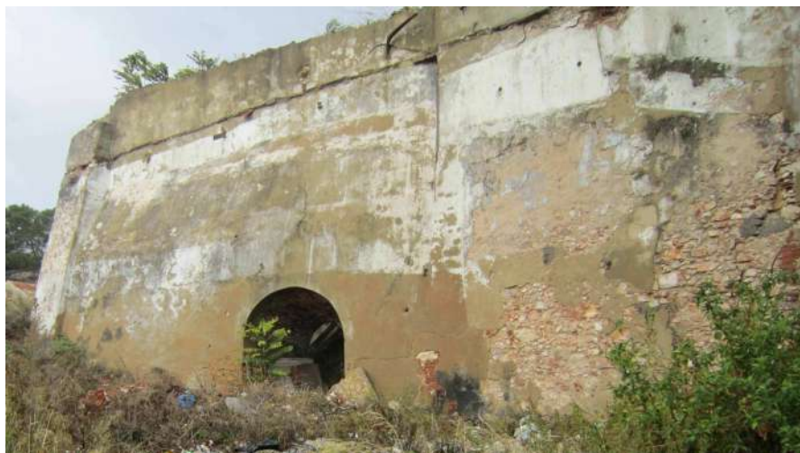
Fig. 4 – Vista do exterior conservado (em parte revestido com cimento e rebocado) da estrutura primitiva contrafortada, com a entrada do forno melhor conservado.
