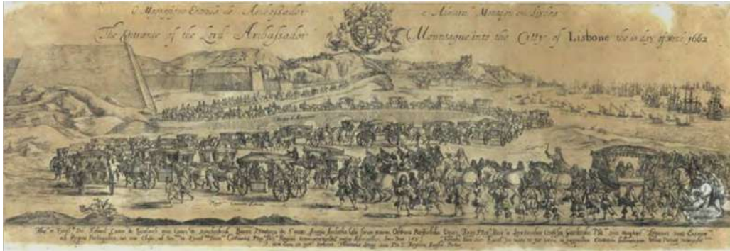
Figura 1. Gravura de Dirck Stoop (séc. XVII). A estrada por onde segue o cortejo e desemboca na Ponte de Alcântara são as Janelas Verdes. (British Museum).
