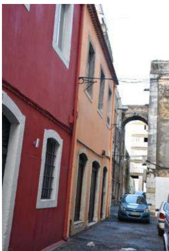
FIGURA 33 – CORREDOR DA TORRINHA 33 A 36 (Fonte: DP/DPT, 2018)
