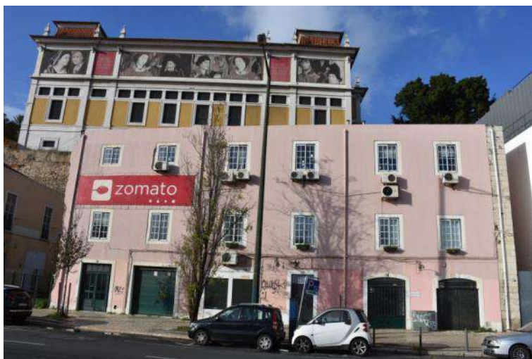
FIGURA 34 – AVENIDA 24 DE JULHO, 102 A 102F (Fonte: DP/DPT, 2018)
