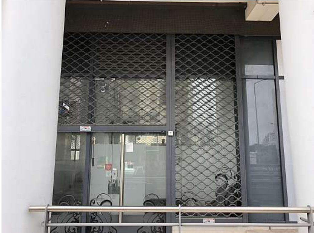
Fotografia da fachada
