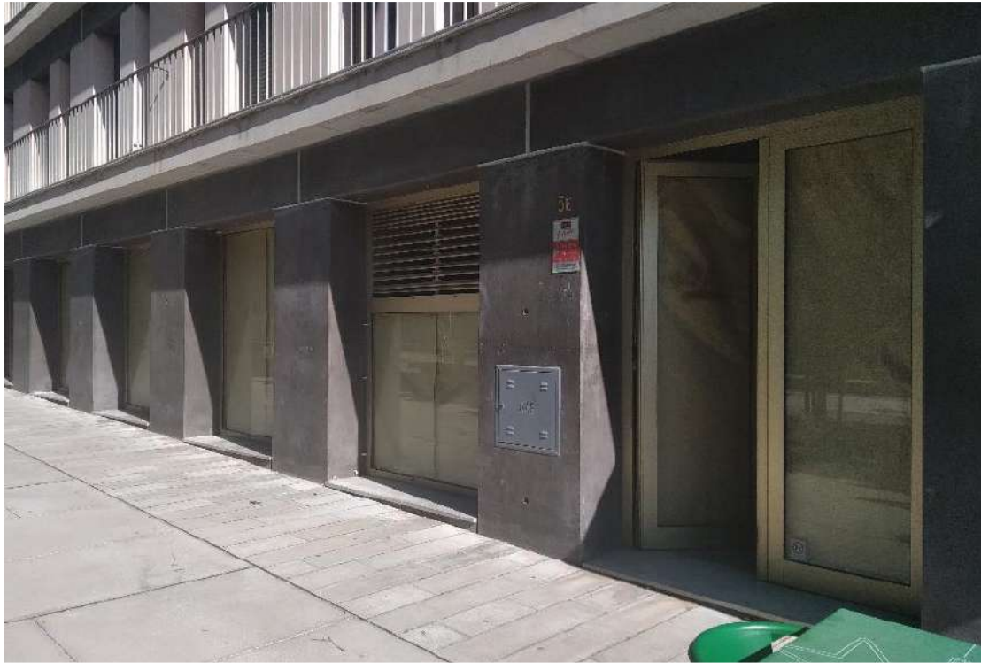
Fotografia da fachada
