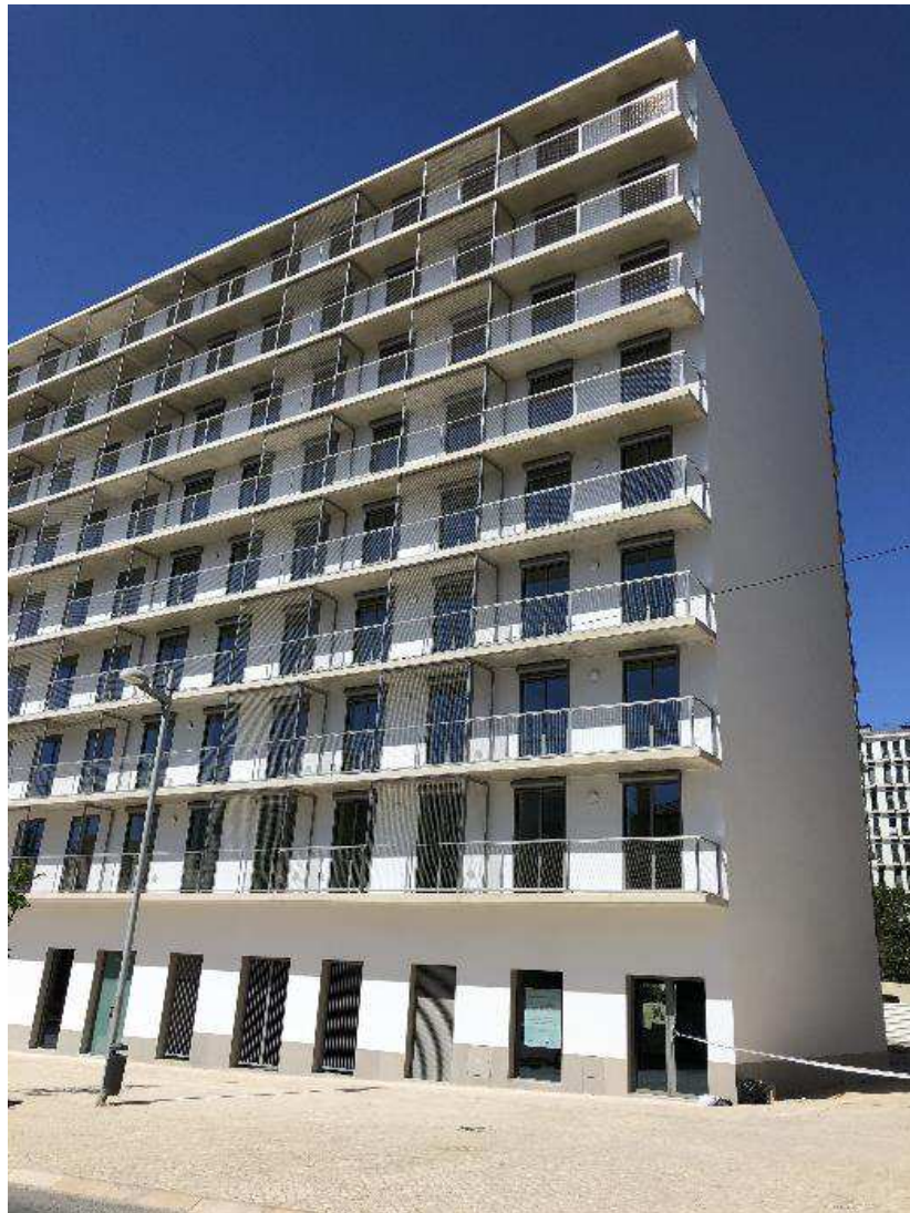
Fachada principal do edifício
