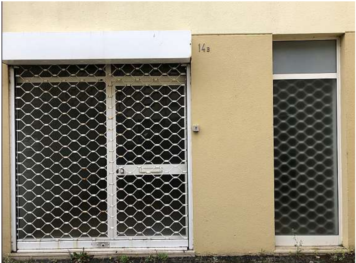
Fotografia da fachada
