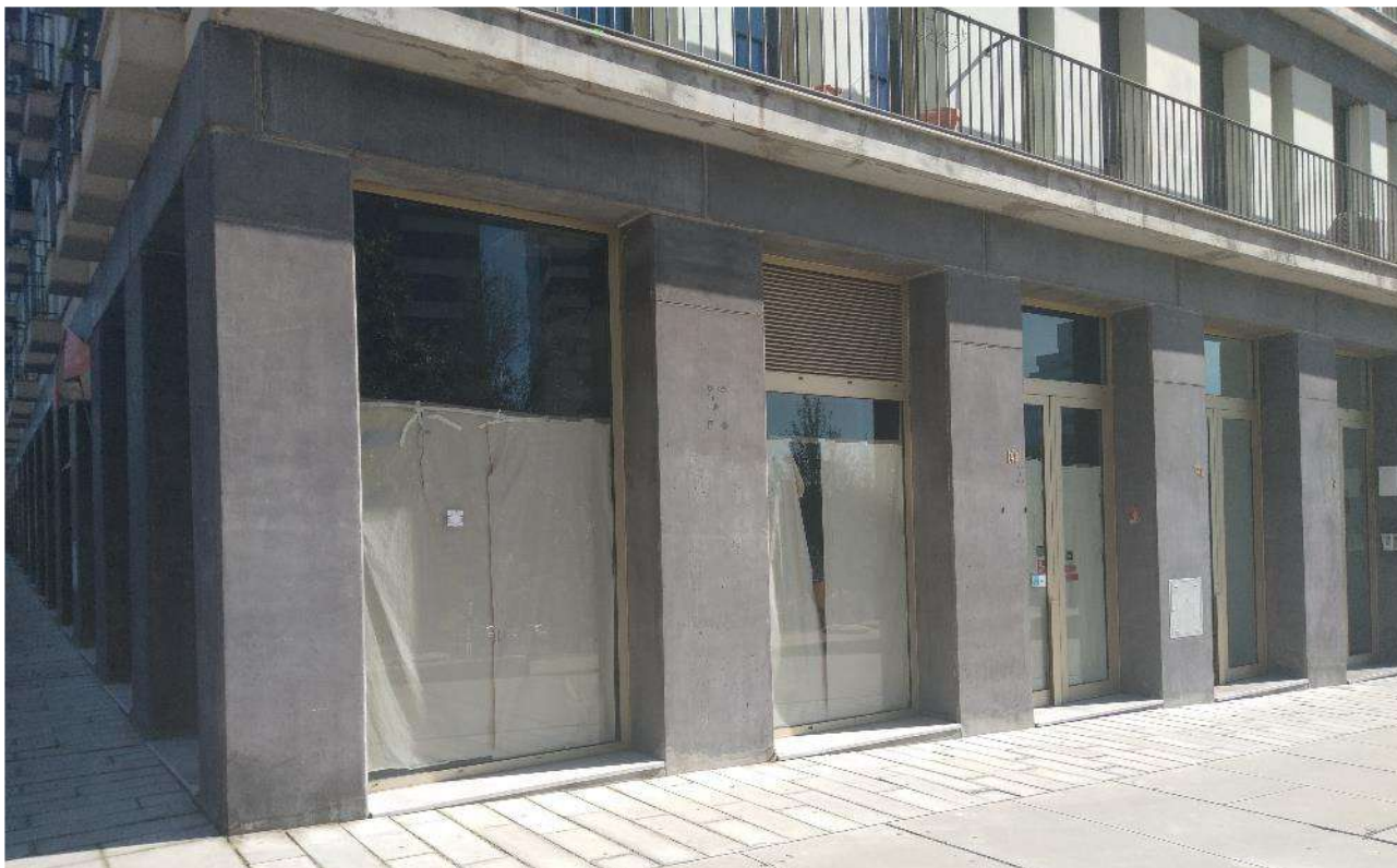
Fotografia da fachada
