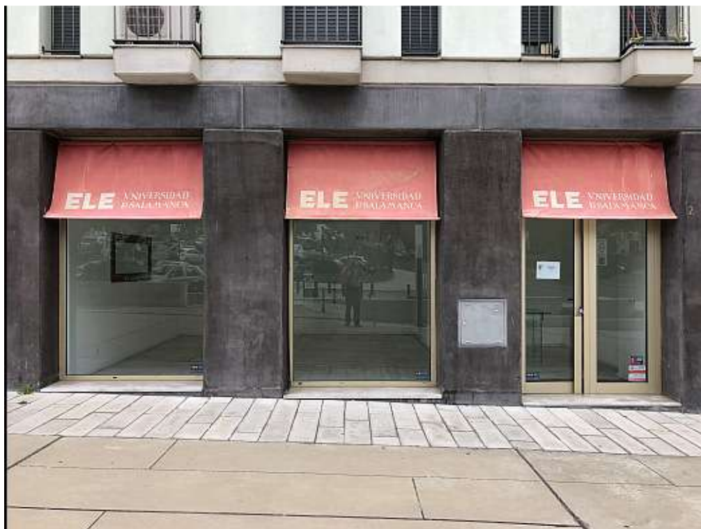
Fotografia da fachada
