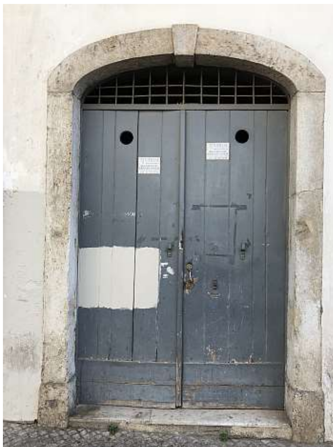
Fotografia da fachada
