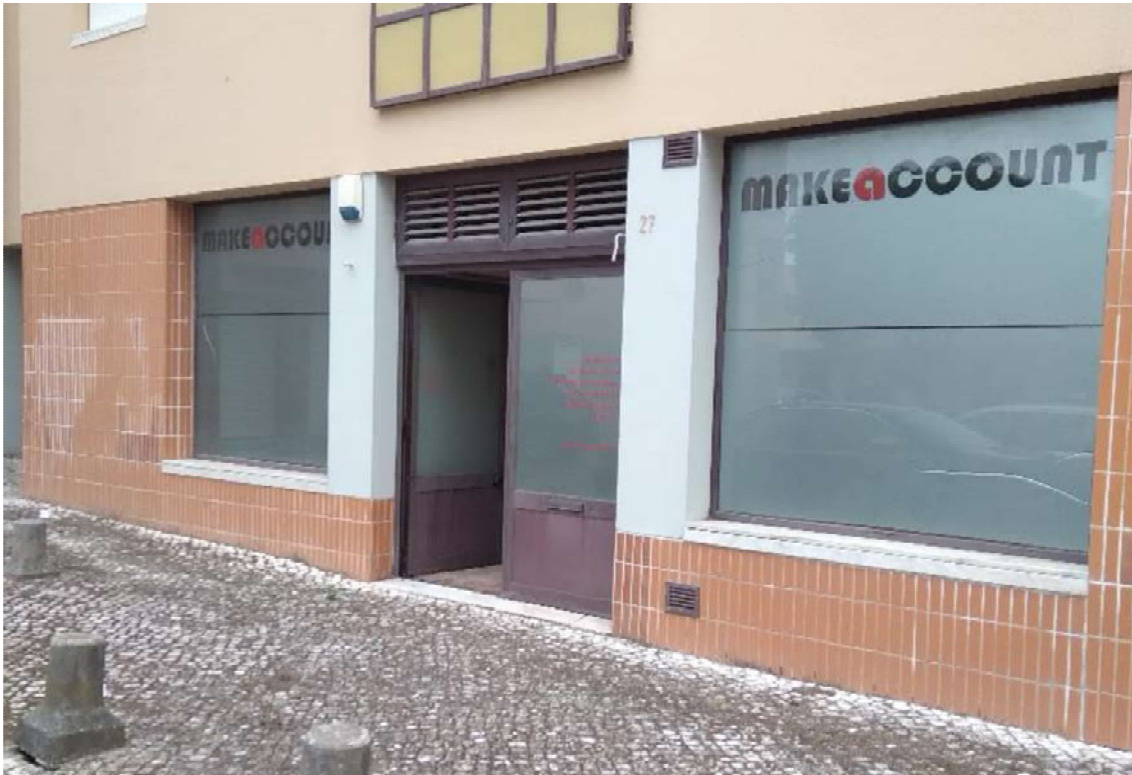
Fotografia da fachada
