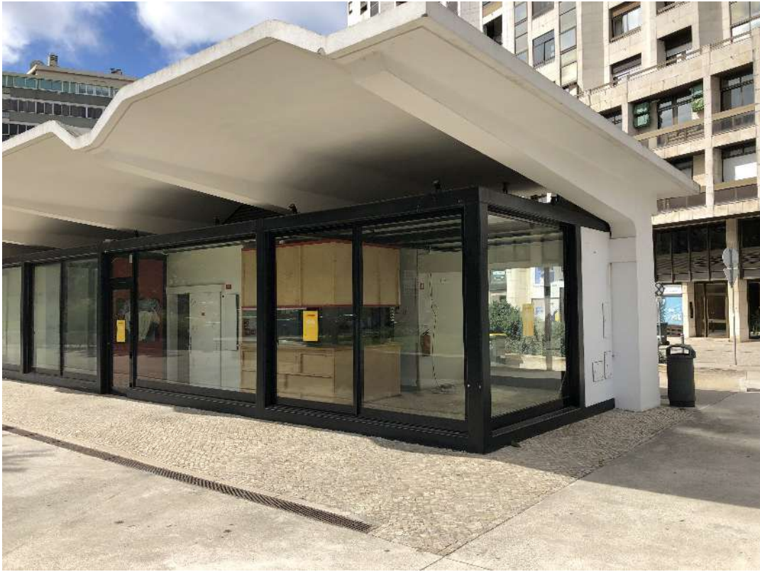
Fotografia da fachada
