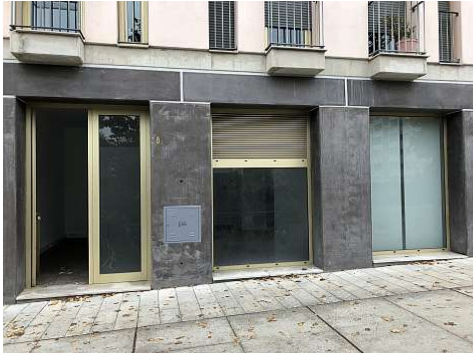
Fotografia da fachada
