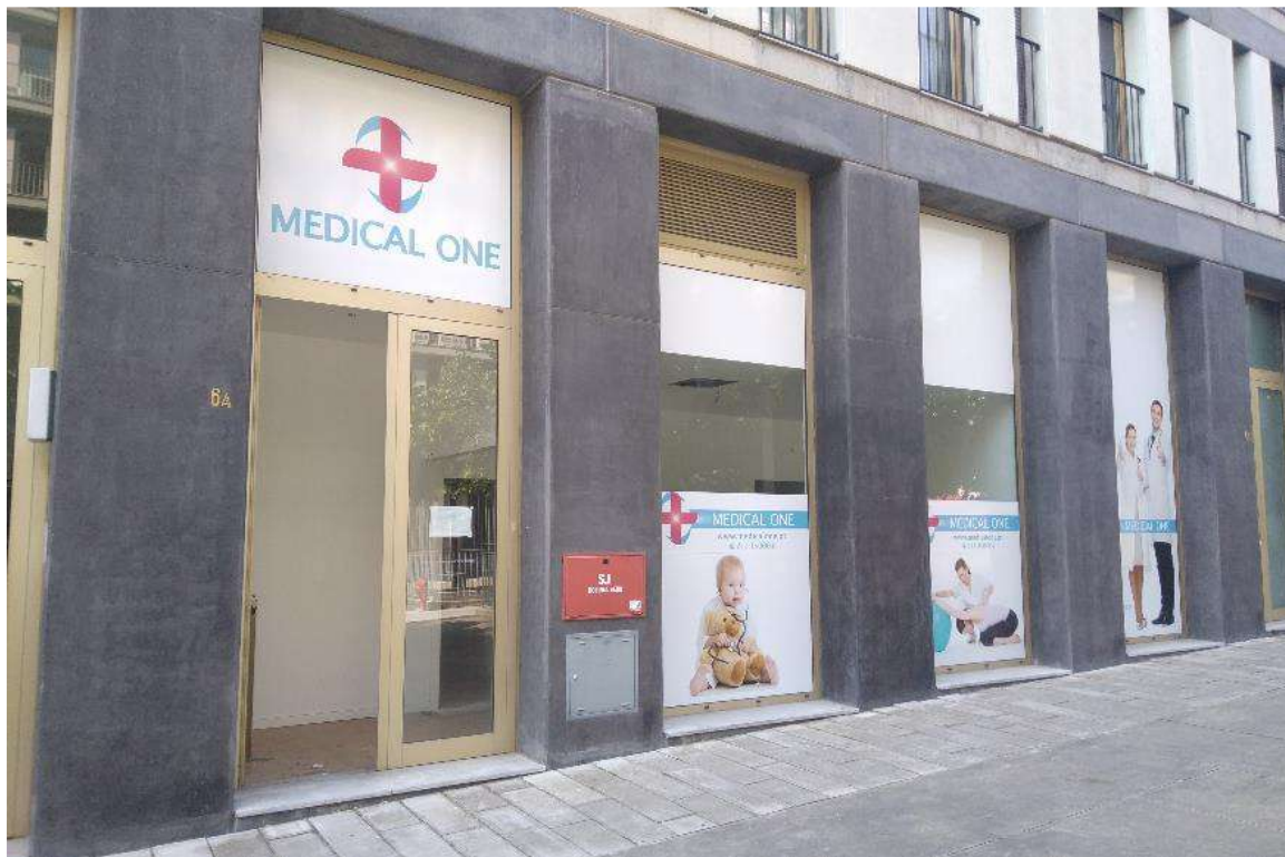
Fotografia da fachada
