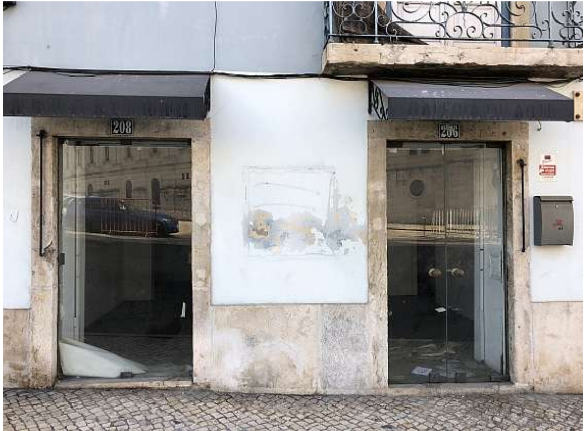
Fotografia da fachada
