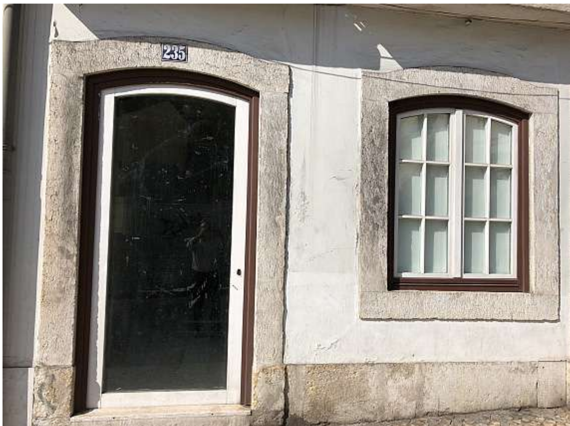
Fotografia da fachada
