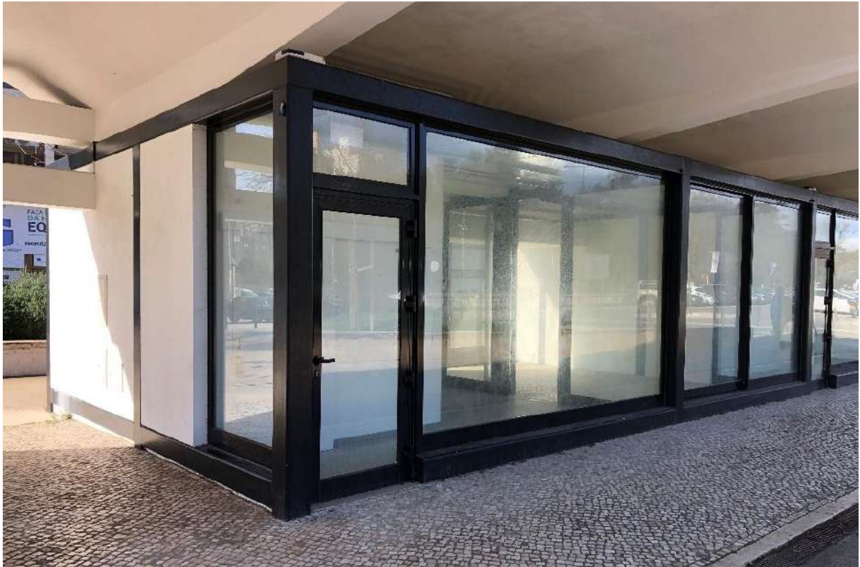
Fotografia da fachada
