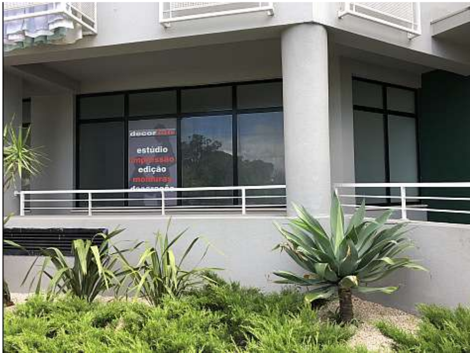
Fotografia da fachada
