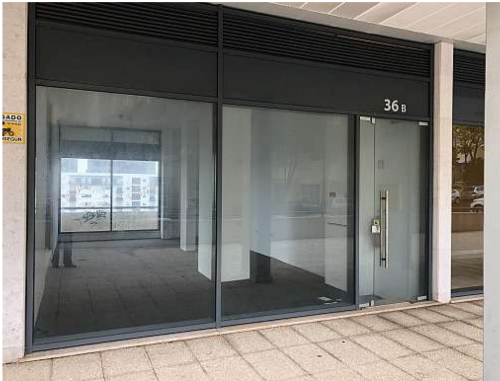
Fotografia da fachada
