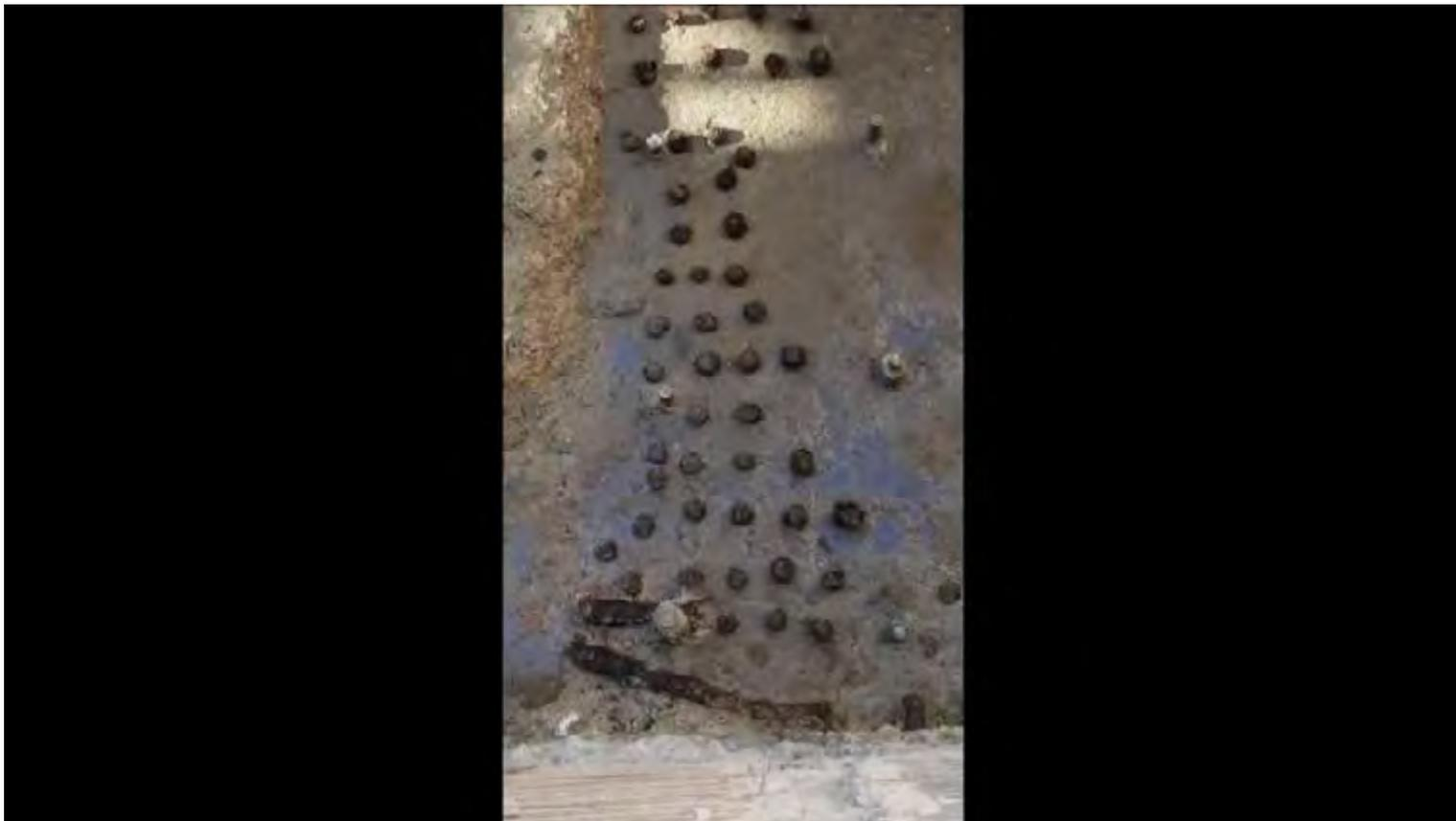
Sobre estas estacas verticais observam-se primeiro as longarinas, que atingem diversos metros de comprimento, por vezes mais de uma dezena, habitualmente aplanadas na base de modo a permitir uma melhor ligação cravadas sob si. As travessas, colocadas perpendicularmente sobre as longarinas, são de menor dimensão, geralmente um pouco mais compridas do que as sapatas que suportam, situando-se a média perto do metro e meio.
