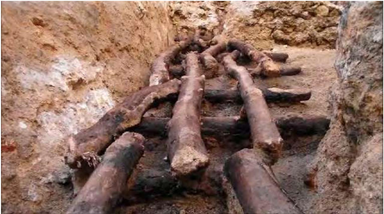
A ligação entre os elementos de madeira é feita com cravos de ferro de grande dimensão, ressalvando-se o facto de nem todas as intersecções das estacas verticais, longarinas e travessas terem sido pregadas.
