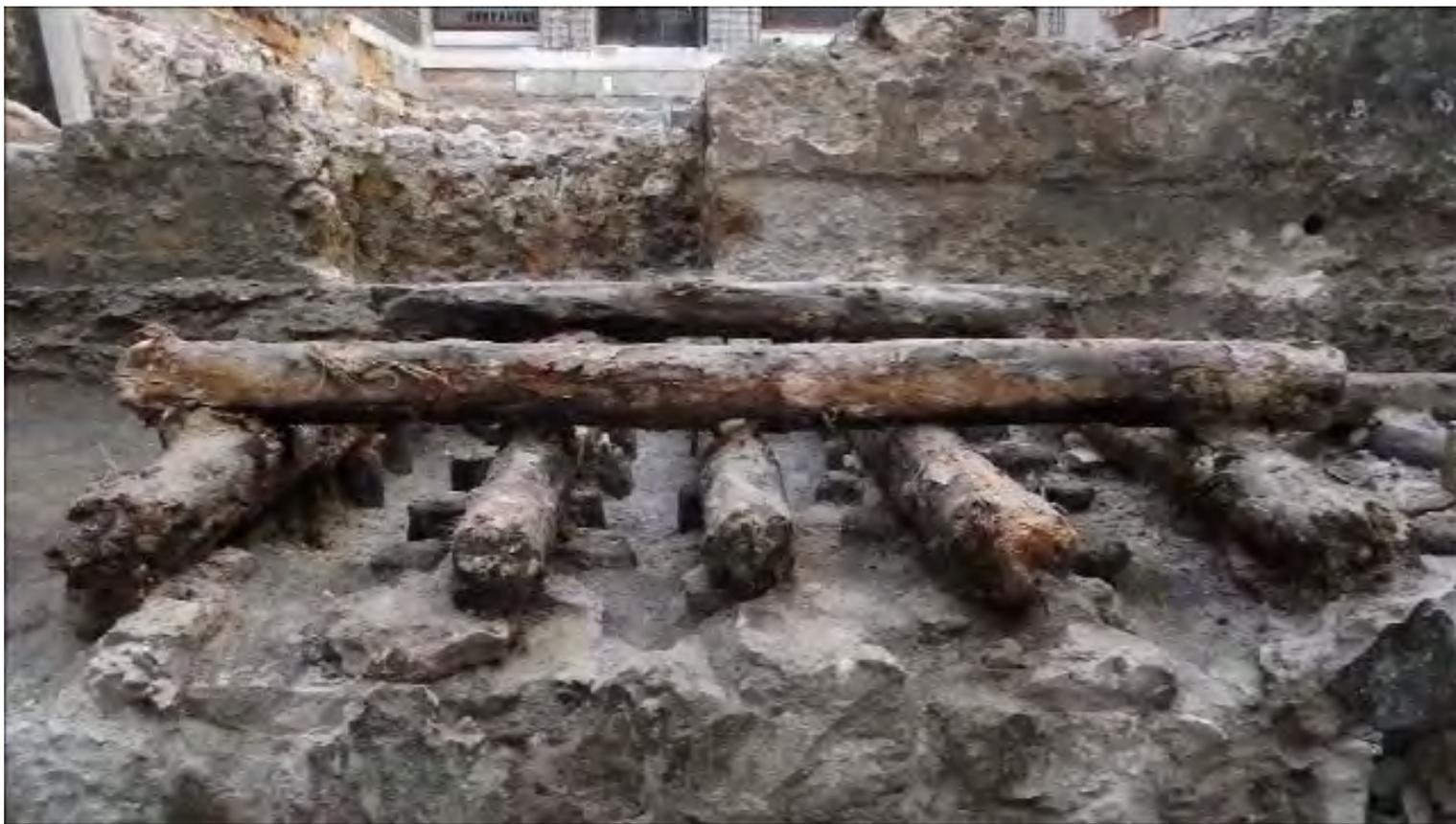
Os conjuntos exclusivamente formados de estacas cravadas na vertical são bastante heterogêneos. Uns tratar-se-ão de reforços pontuais no interior, realizados já após a construção das paredes mestras, outros de bases de pilares internos. Destes conjuntos, alguns apresentavam cotas de topo cifradas já nos 2,5 a 2,6 metros acima do nível médio do mar, ou seja, já fora do lençol freático, fenómeno que provocou a sua acentuada deterioração. (Slideshow G)
